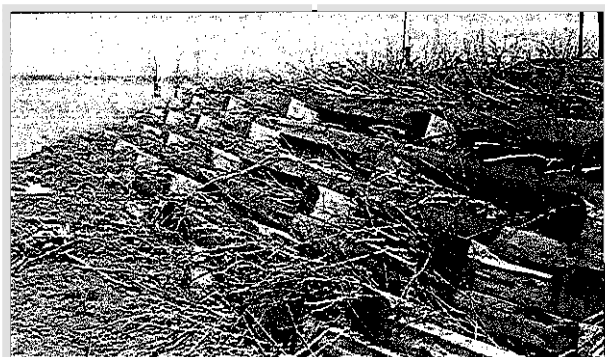
Les branches de saule sont insérées entre les différents étages du caisson.
