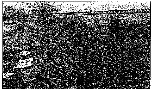
Les branches de saule sont appuyées contre le sol à l'aide d'un treillis métallique.
