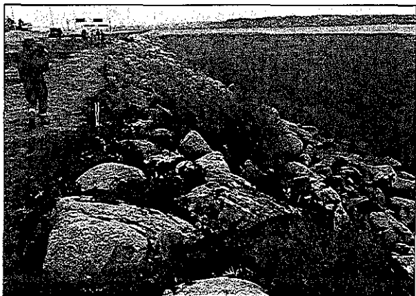
Vue générale d'un enrochement à la fin des travaux de végétalisation.
