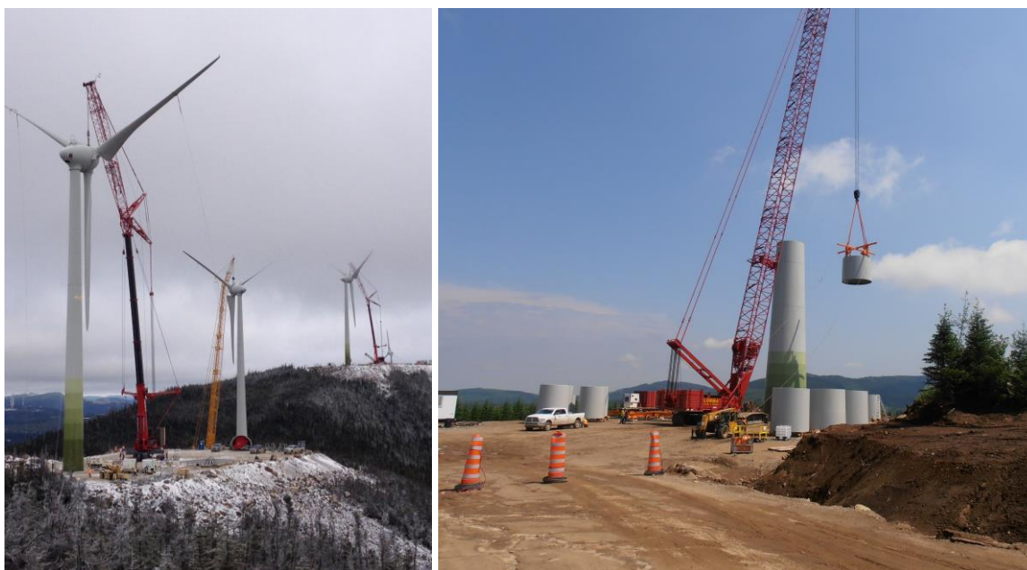
Figure 3.4 Assemblage d'une tour d'éolienne par section
