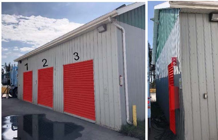
Figure 23 : Bâtiment compresseurs et génératrice
