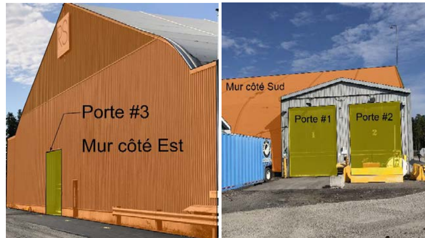
Figure 24 : Bâtiment de conditionnement et d'alimentation
