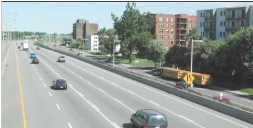
Photo 5-1 — Zone résidentielle subissant un climat sonore fortement perturbé : autoroute 20 (route 132) à Longueuil.
