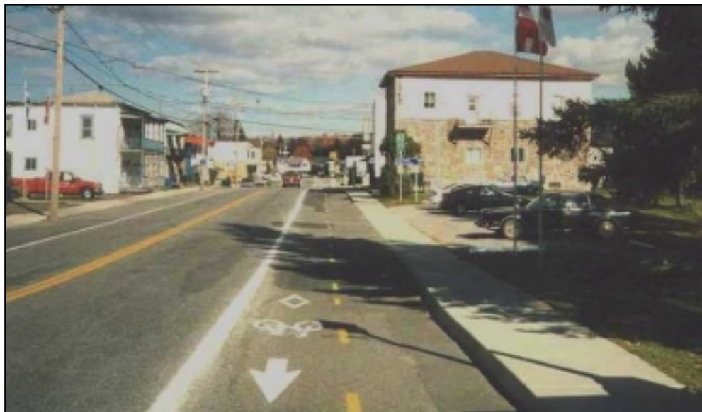
Photo 6-4 – Bande bidirectionnelle sans glissières ni poteaux délinéateurs
