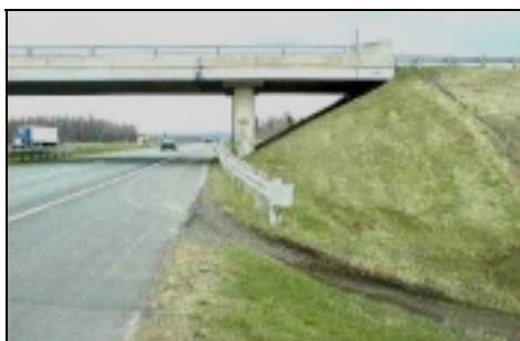
Photo 6-5 – Un sentier illégal de VHR sur l'accotement d'une autoroute pour le franchissement d'une structure
