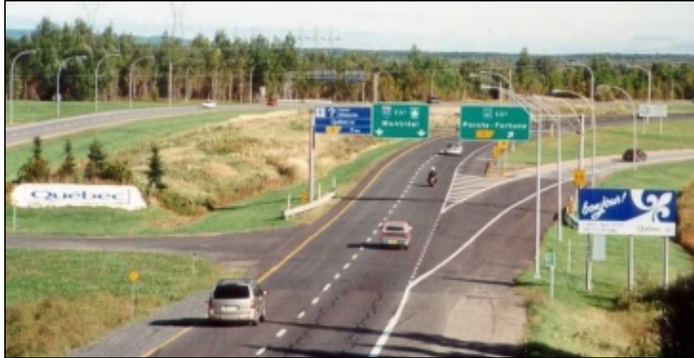
Photo 5-14 — A-40 à Pointe-Fortune : entrée au Québec par la frontière ontarienne
