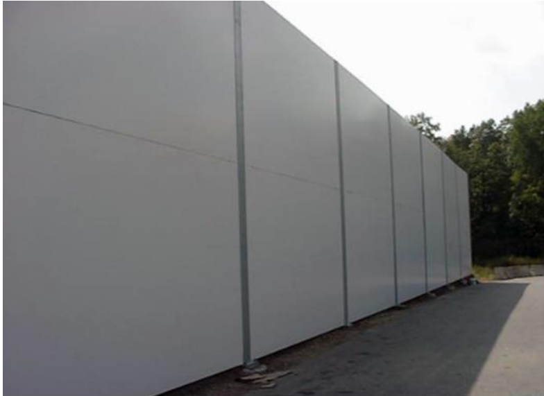
Figure 9: Exemple typique d'un écran réfléchissant (Source : Kinetics)
