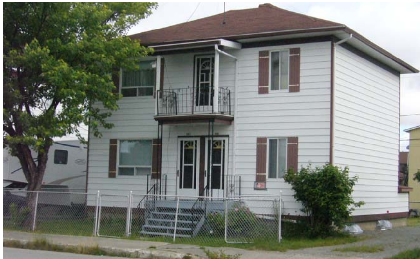
Photo 11 : Exemple de maison Four Squares (500 et 502, de la Paix, 1939)
