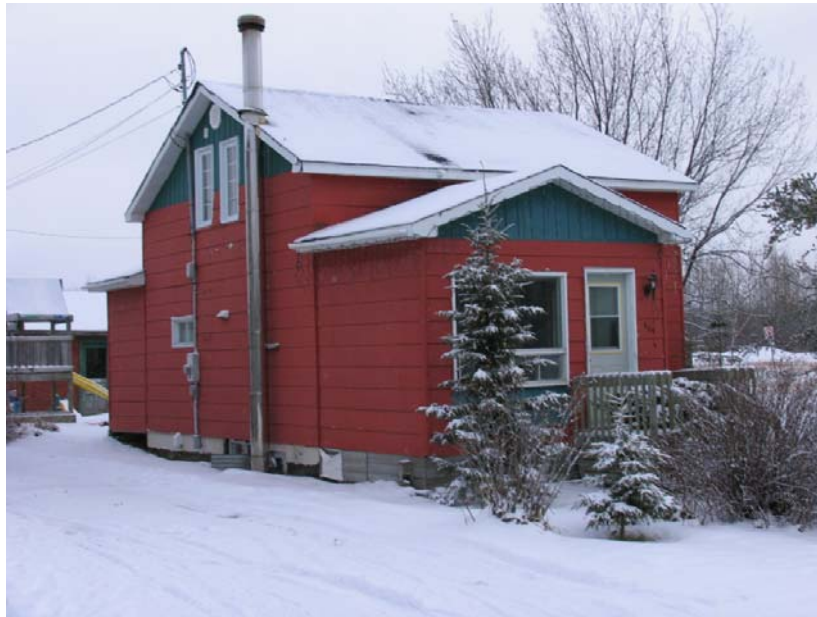
Photo 5 : Exemple de maison de colonisation (550, des Pionniers, 1939)
