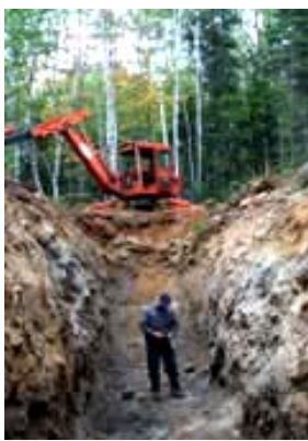
1. Décapage (ou tranchée) en exploration (tiré de www.virginia.qc.ca )
