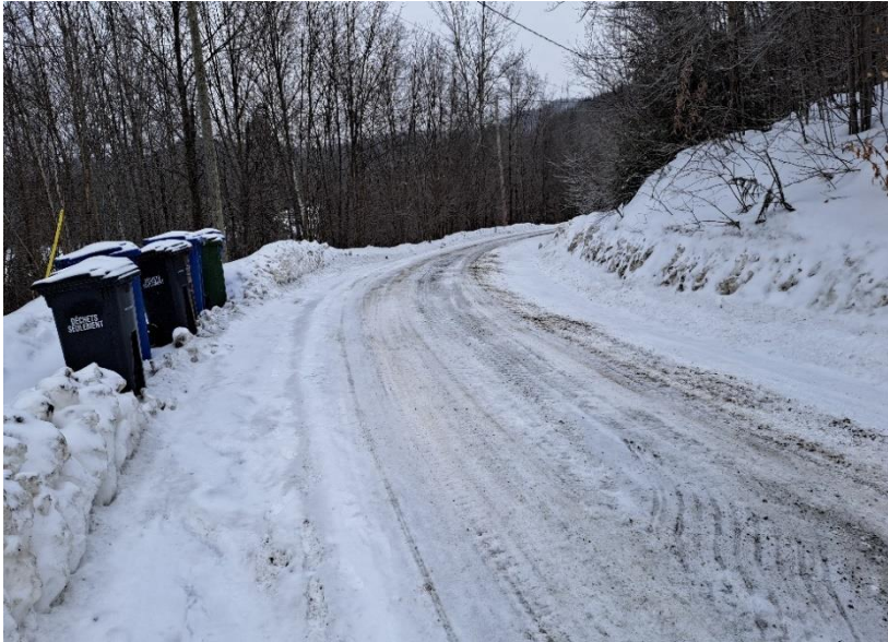
Chemin Bûcherons - Courbe à 90 degrés avec devers non conforme et visibilité très réduite
