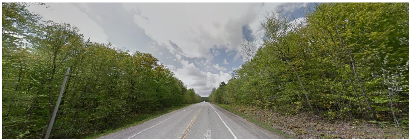
Figure 2-3 : Accès Est - Vue de la DVVG
