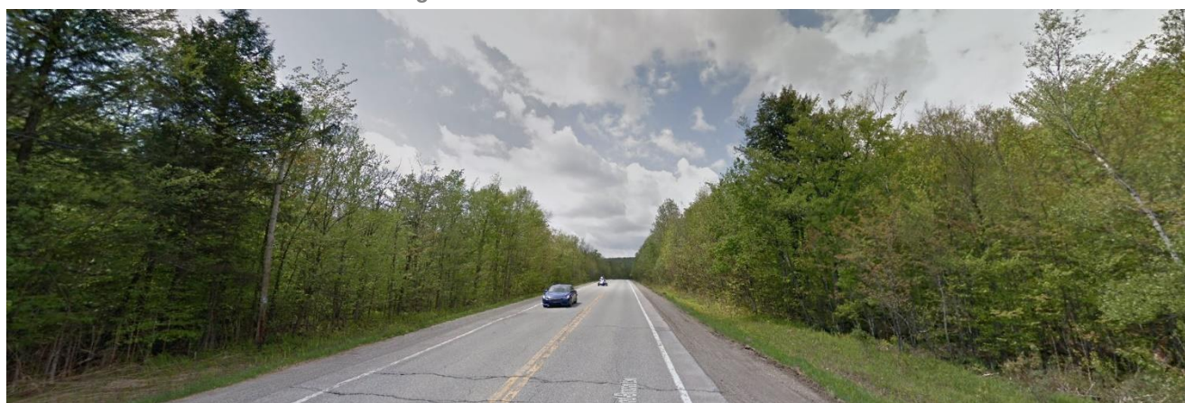
Figure 2-4 : Accès Ouest - Vue de la DVVD
