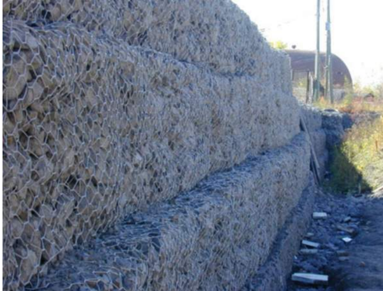
Figure 15 – Exemple de mur en gabions (Innovex)
