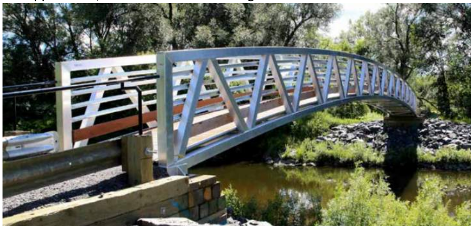
Figure 13 – Exemple de passerelle en aluminium installée sur des caissons en bois (extrait du catalogue de MAADI Group)
