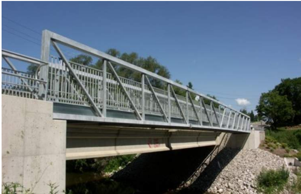
Figure 10 – Exemple de passerelle piétonnière en acier galvanisé, sans cambrure et construite à proximité d'un pont (Photo : Algonquin Bridge)
