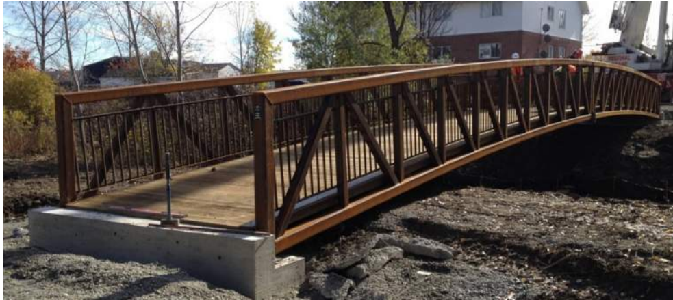
Figure 9 – Exemple de passerelle en acier intempérique et munie d’une cambrure (Photo : Algonquin Bridge) 3
