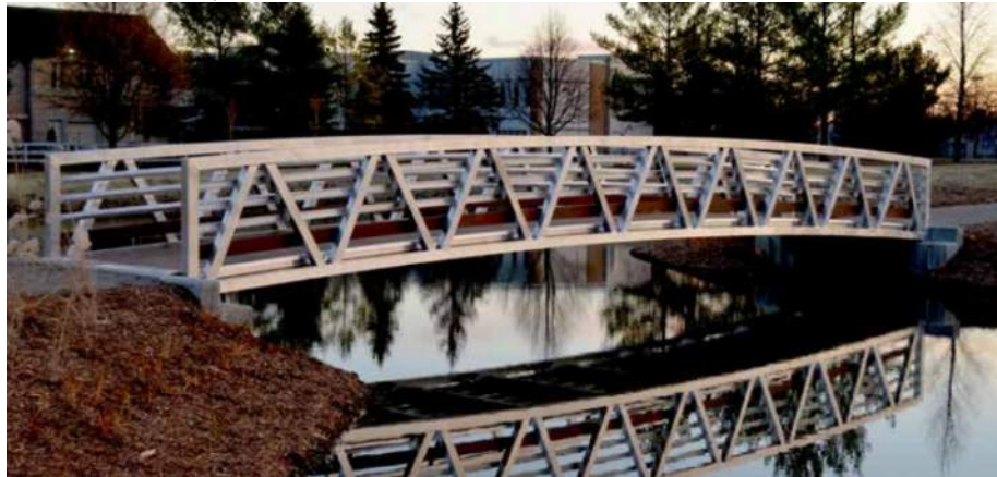
Figure 11 – Exemple de passerelle en aluminium installée sur une fondation en béton (extrait du catalogue de MAADI Group)
