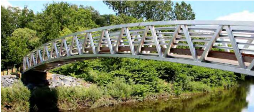
Figure 7 – Exemple de passerelle en aluminium avec cambrure (Photo : MAADI Group) 2
