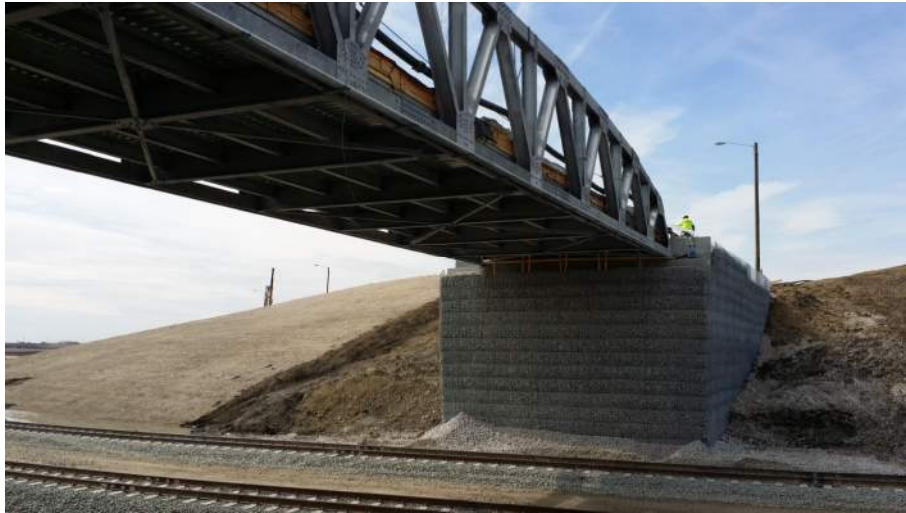
Figure 14 – Pont en treillis installé sur des culées en sol renforcé de type TSM Treillis (fourni par AIL)
