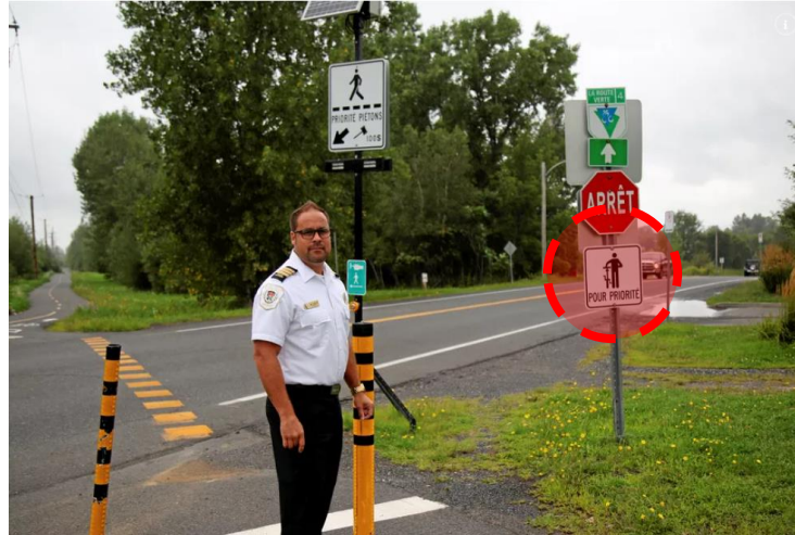
Figure 1 : Passage pour personne avec signaux lumineux sur une piste cyclable
