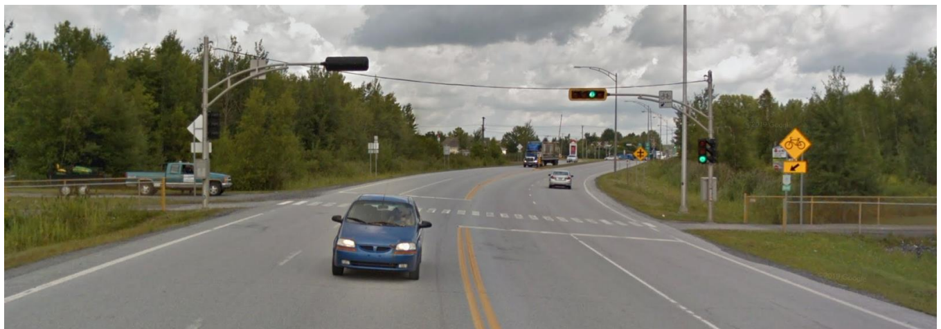
Figure 2 : Traverse pour cyclistes avec feux de circulation
