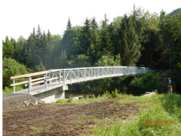
Passerelle à treillis à tablier inférieur Parc du Mont Mégantic
