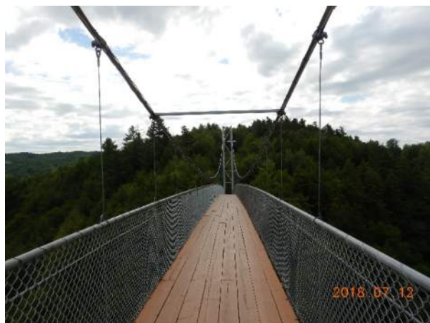
Passerelle suspendue à Coaticook
