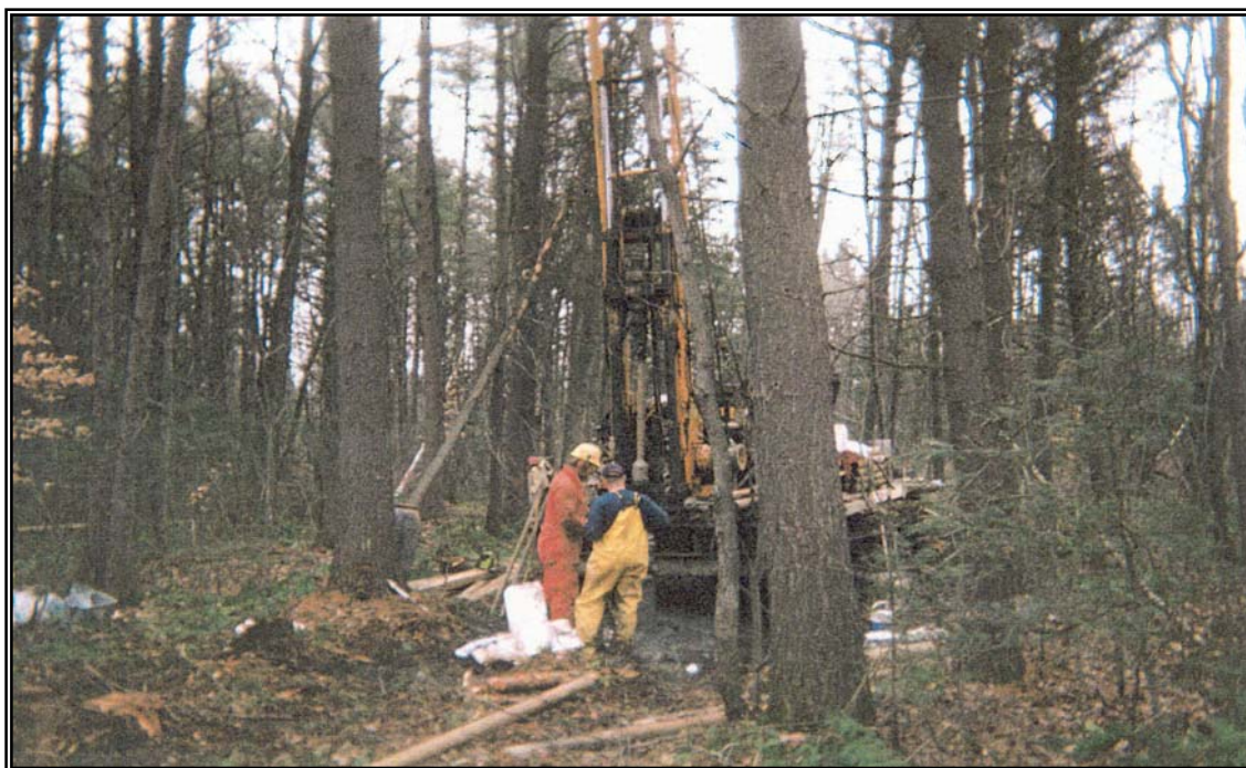
PHOTO 2 : Réalisation d'un forage au site S-25. Vue vers l'est
