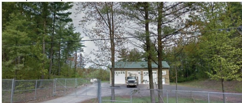
Figure 4-5 : Point de vue 5 - Entrée du garage municipal de la MRC Les Chenaux
