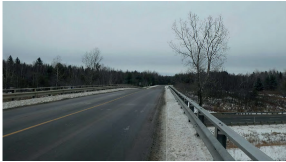
VUE VERS LE SUD DE LA ROUTE SAINTE-MARIE SUR LE VIADUC SURPLOMBANT L'AUTOROUTE 40
