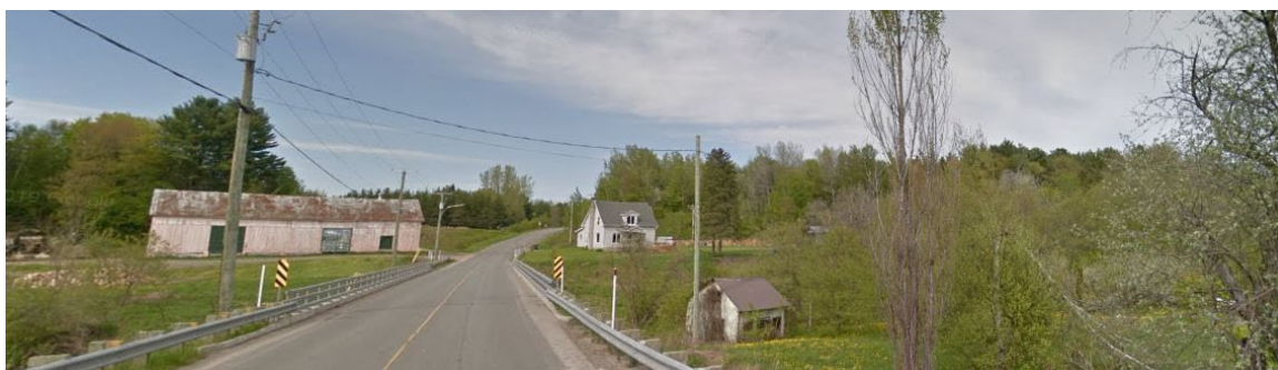
Photo 4-12 : Quelques résidences et exploitations agricoles situées près du pont de la rivière Champlain sur la route Sainte-Marie
