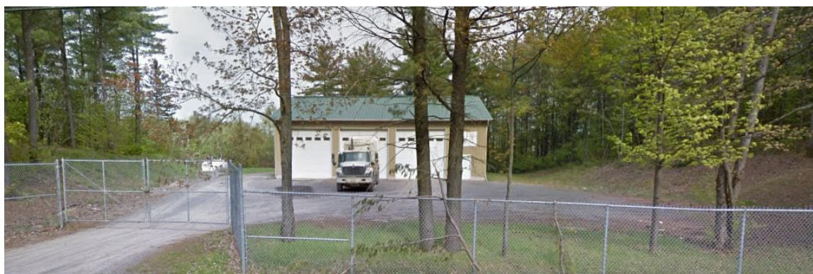
Photo 4-16 : Garage de la MRC
