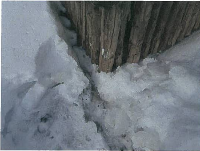
Coin nord-ouest du quai
