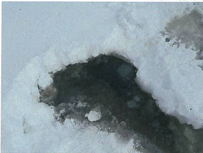
Coin nord-est du quai (vue rapprochée)
