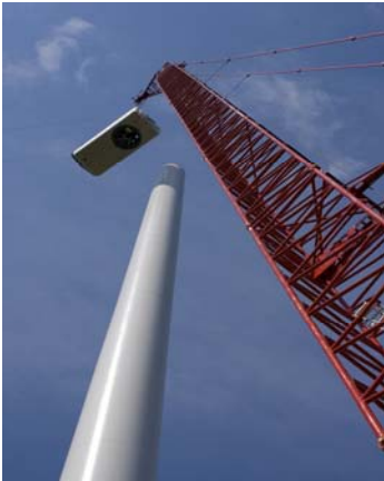
Placement d'une nacelle sur sa tour
