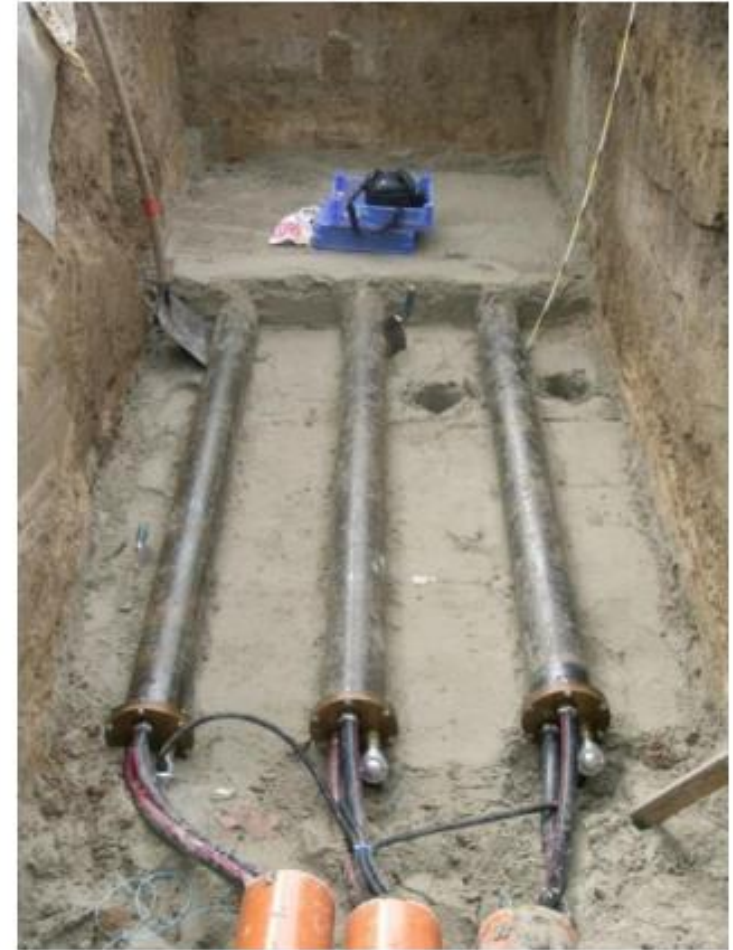
Système de chauffage à l'eau chaude
