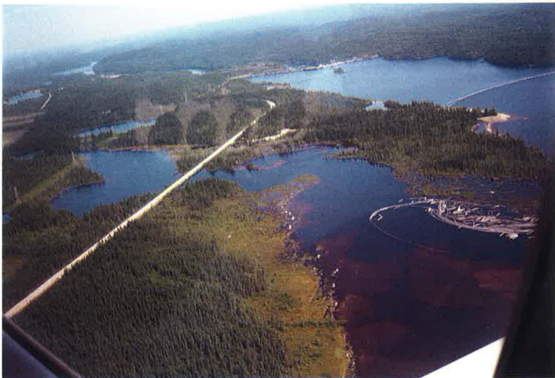
Figure 35 : Vue aérienne des milieux riverains en amont de la centrale Chute-du-Diable (I-57, 58 et 59).
