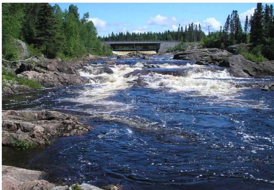
Photo 7-70 : Débit de 12 m 3 /s au site de la centrale Minashtuk
