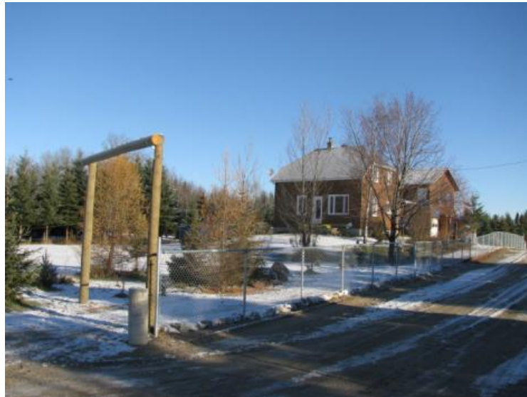
Photo 7-45 : Bâtiment d'accueil du centre d'éco-aventure Aventuraïd localisé dans la portion ouest de la zone d'étude, le long du rang de la Pointe
