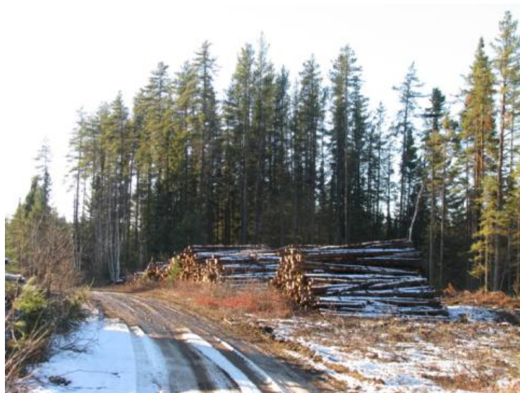
Photo 7-49 : Travaux de déboisement dans le cadre d'un projet d'aménagement de bleuetière de type forêt/bleuet sur le territoire public de Notre-Dame-de-Lorette
