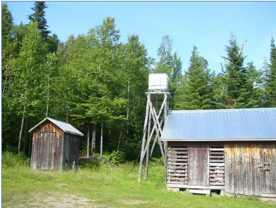
**Figure 5.16** Deux remises associées à un chalet, au lac Long. Celle de gauche abrite la pompe à essence utilisée pour remplir un réservoir de plastique, afin d'alimenter le chalet en eau, par simple gravité.
