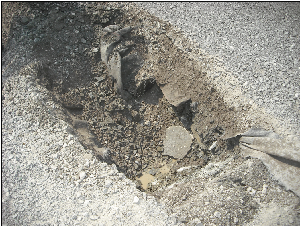
Photo 8 Contexte stratigraphique de la partie nord (remblai, géotextile, remblai, géotextile, argile)
