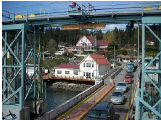
Voie hors trafic
