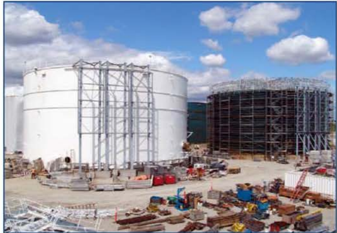
Illustration 4 : Réservoir en construction au parc de carburant aéroportuaire de Toronto
