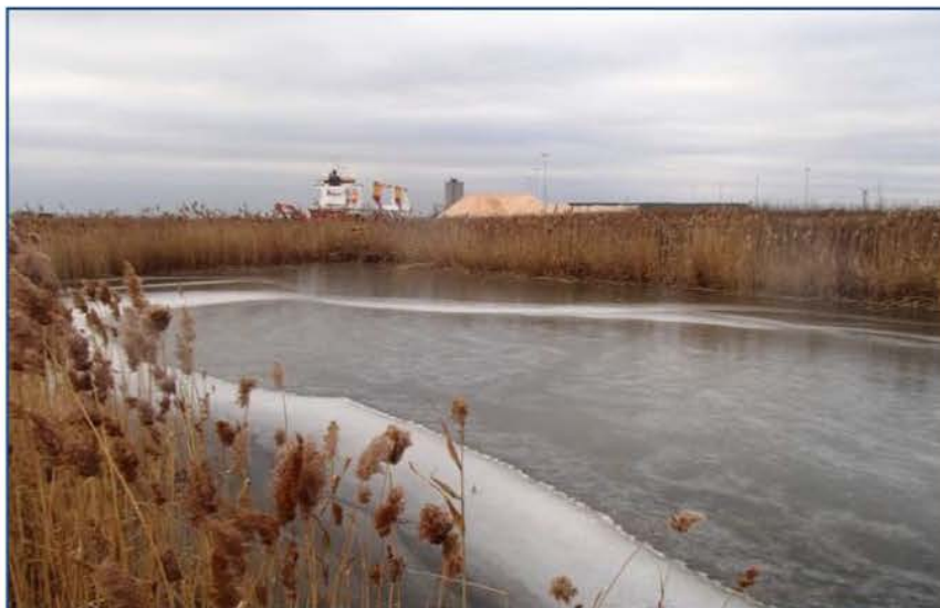
Illustration 16 : Bassin de rétention du Site 1
