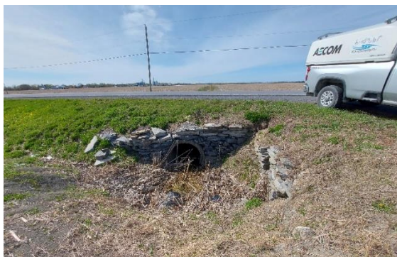
Photo 6 : Exemple d'écoulement souterrain, dans un ponceau, sur près de 20 m (site CE33, en amont de la traversée)
