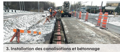
3. Installation des canalisations et bétonnage
