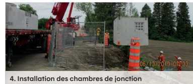
4. Installation des chambres de jonction
