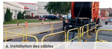
6. Installation des câbles
