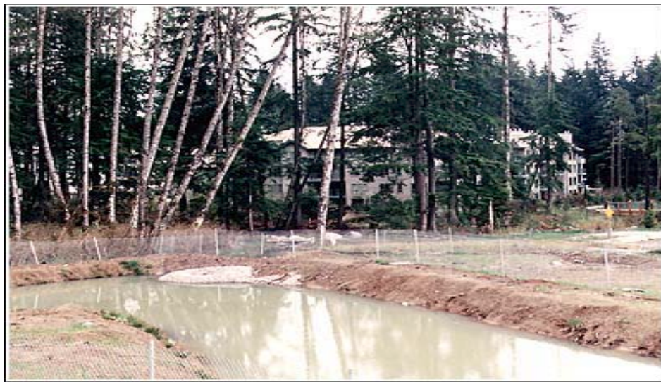
Figure 4.9 Bassin de rétention en milieu urbain (Tiré de North Vancouver District, 1997)
