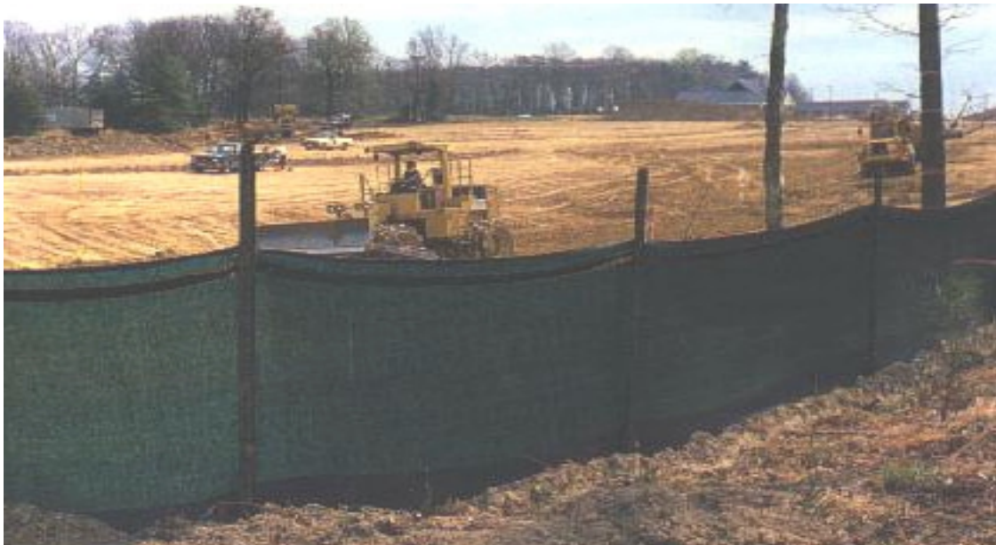
Figure 4.8 La clôture à sédiment (Tiré de North-Vancouver District, 1998)
