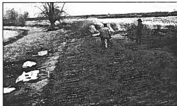
Les branches de saule sont appuyées contre le sol à l'aide d'un treillis métallique.
