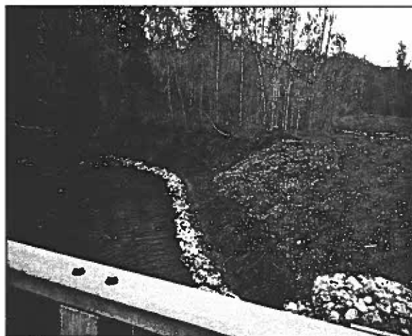
L'enrochement est placé dans le bas de talus et les sections supérieures ont été remises en végétation.
