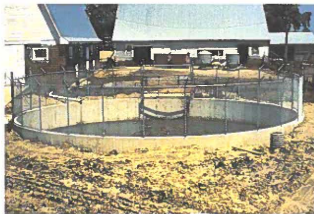
Structure d'entreposage du lisier
