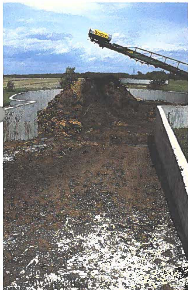
Structure d'entreposage du fumier
