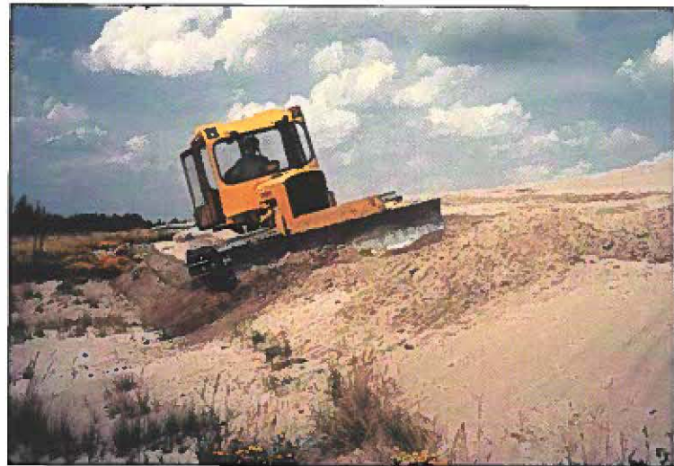
Travaux de nivellement des pentes d'un parc à résidus de la mine Niobec au Saguenay
