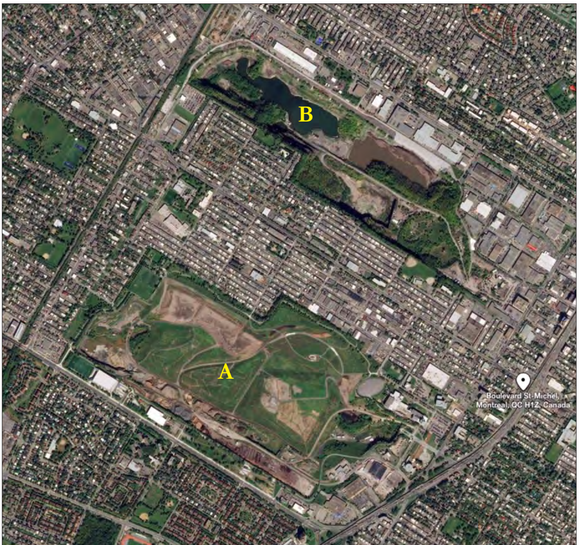
Figure 6.5 Vue de la carrière Miron (A) et de la carrière Francon, qui deviendra Limoges (B) Bing Carte
