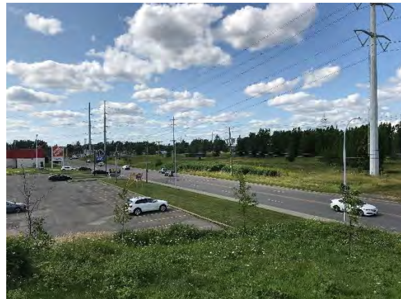
Photo 4 : Vue sur le terrain du nouveau poste d'Anjou et des commerces
