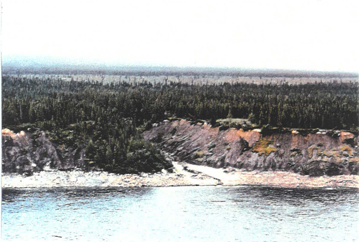
Photo 18 a – Après la dérivation de la rivière Caniapiscou (km 5,5, rive droite, le 96-09-12)
