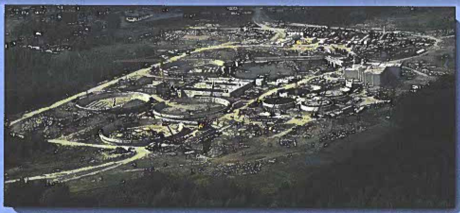
Station d'épuration de la CUO durant sa construction
