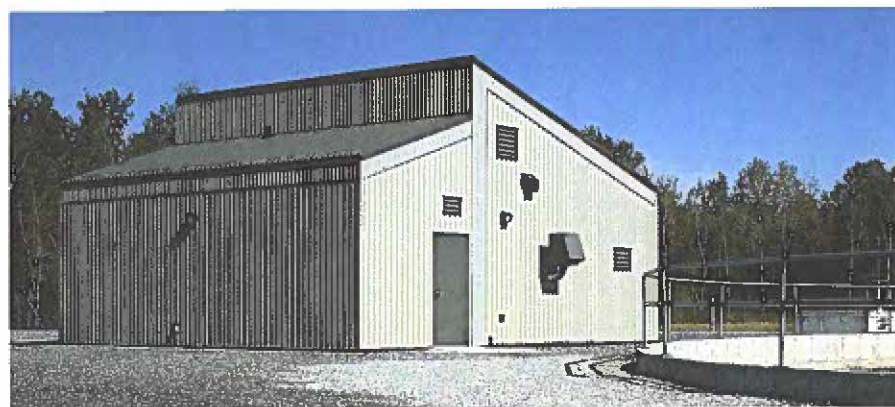
Station d'épuration de St-Alexandre.
