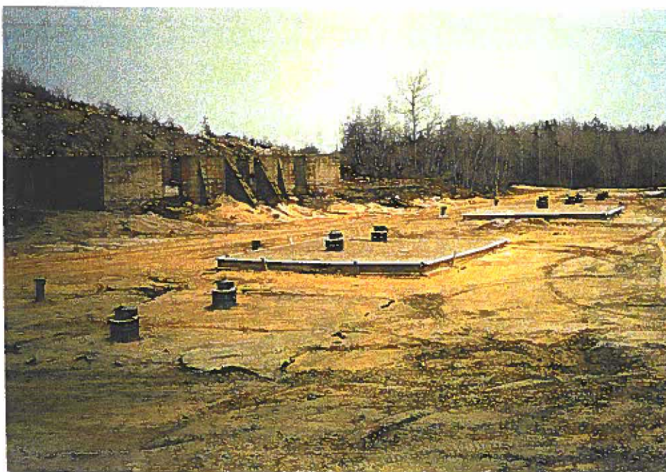
Cellule de démonstration au site Eustis utilisant des rejets de cimenteries
