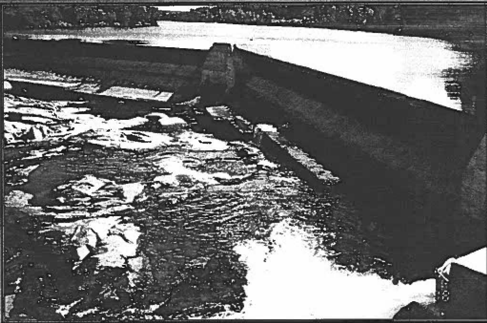
Écoulement via le pertuis ( 2 \text{ m}^3/\text{s} )
