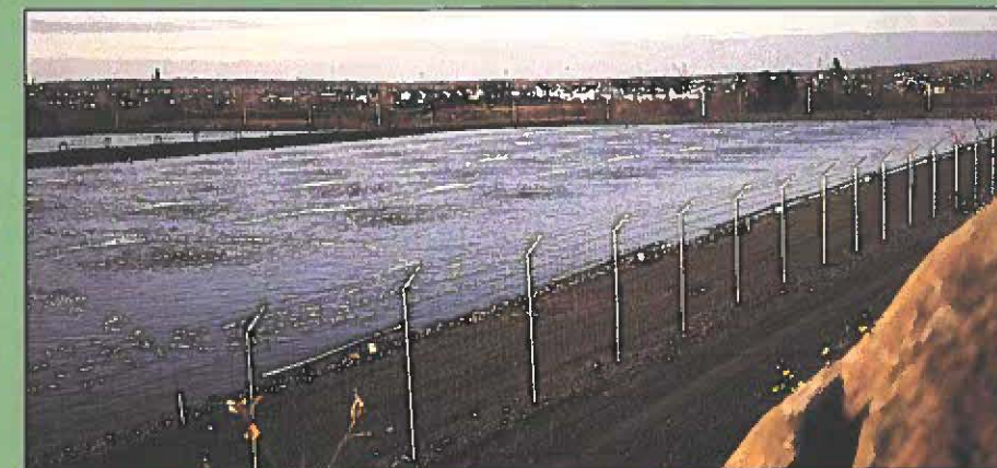
Étangs aérés de Saint-Jean-Chrysostome, mis en service en décembre 1988
