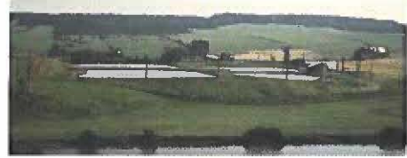
Le traitement conjoint des eaux usées de Saint-Joseph-de-Beauce (Y) et de Vallée-Jonction est assuré par des étangs aérés.
