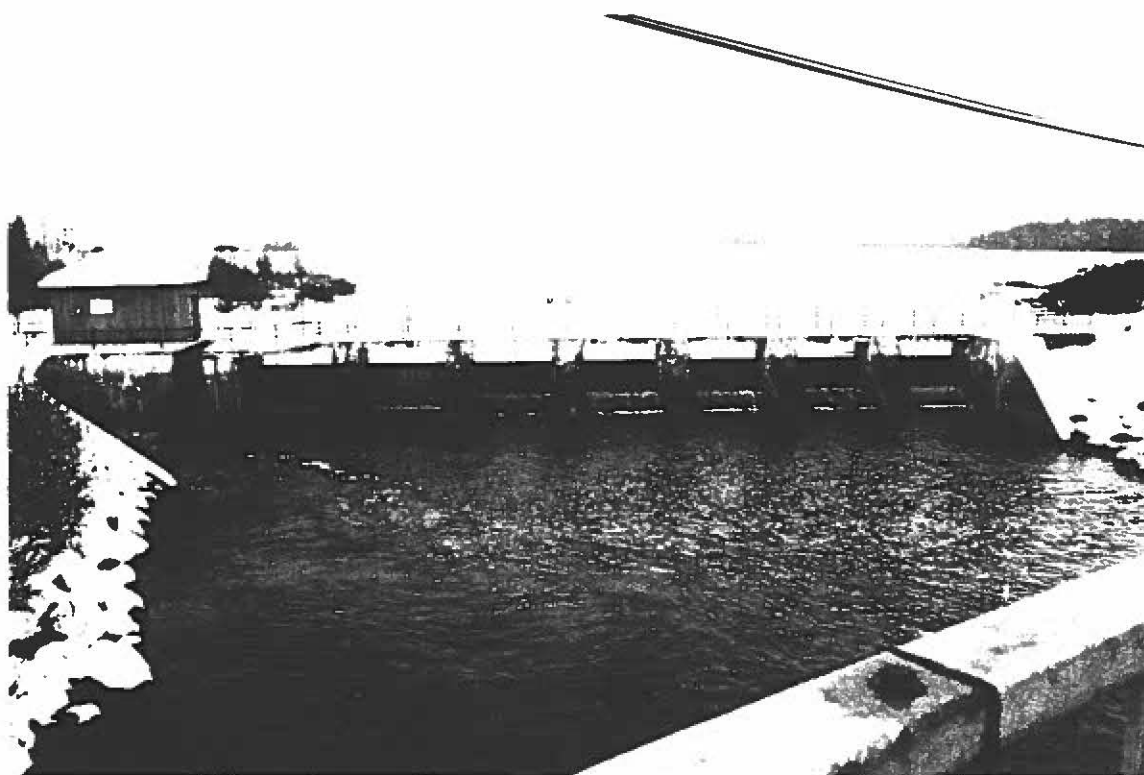
PHOTO 4. Barrage de gestion de l'eau à l'exutoire du lac Saint-Charles.
