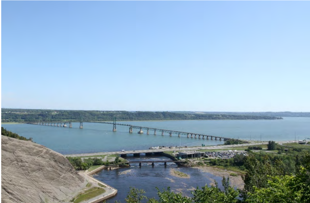
Figure 5-6 Vue du haut de la chute Montmorency du pont existant
