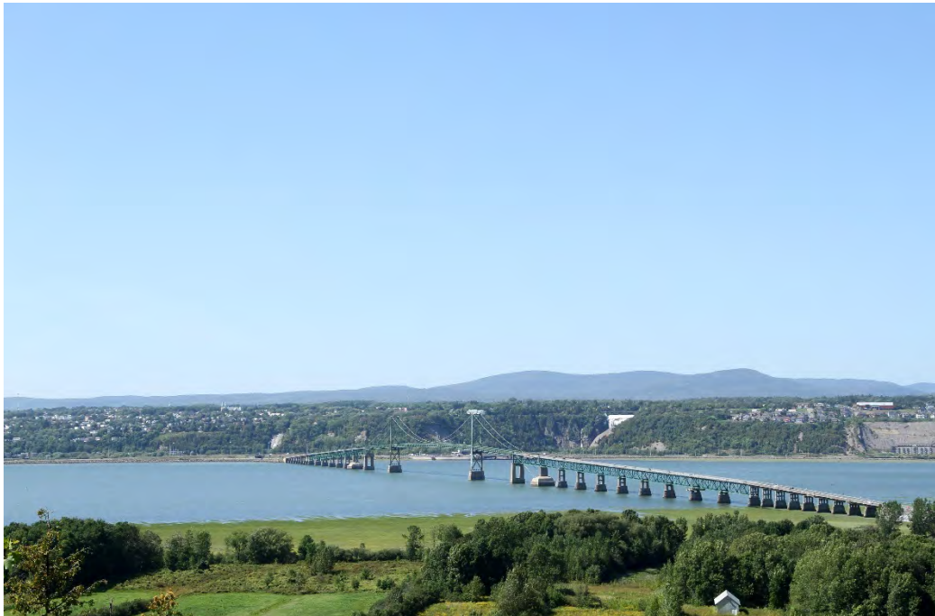
Figure 5-4 Vue du pont existant à partir de l'île d'Orléans
