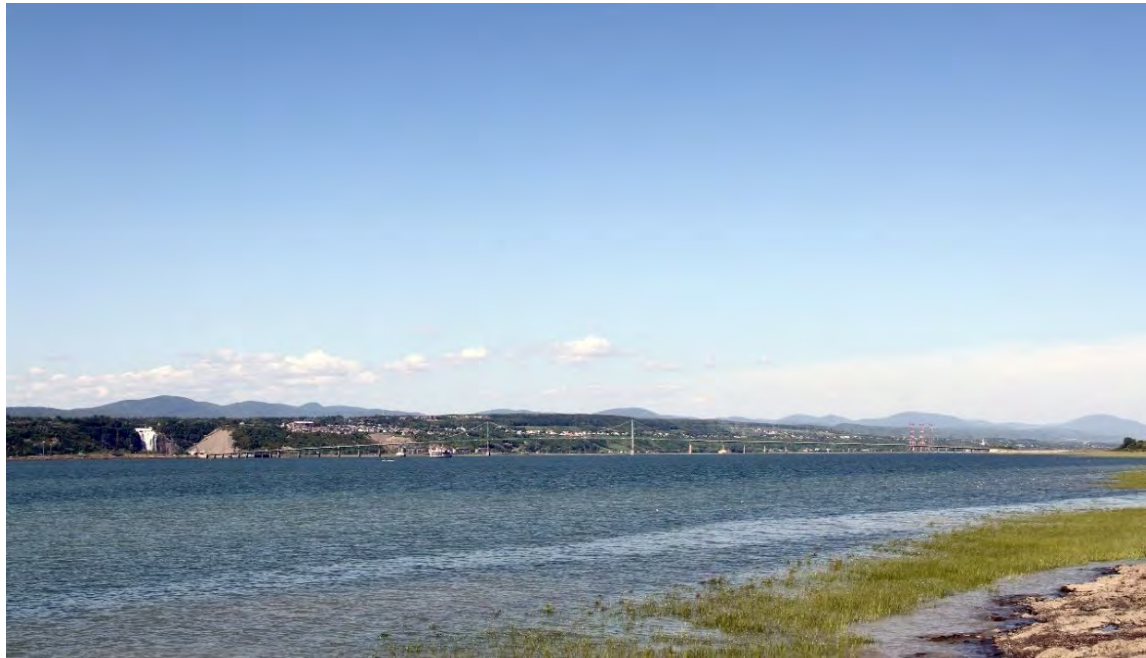
Figure 5-2 Vue du pont existant à partir de la grève de Sainte-Pétronille
