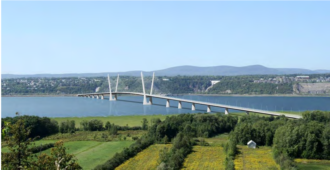
Figure 2-6 Vue du nouveau pont à partir de l'île d'Orléans
