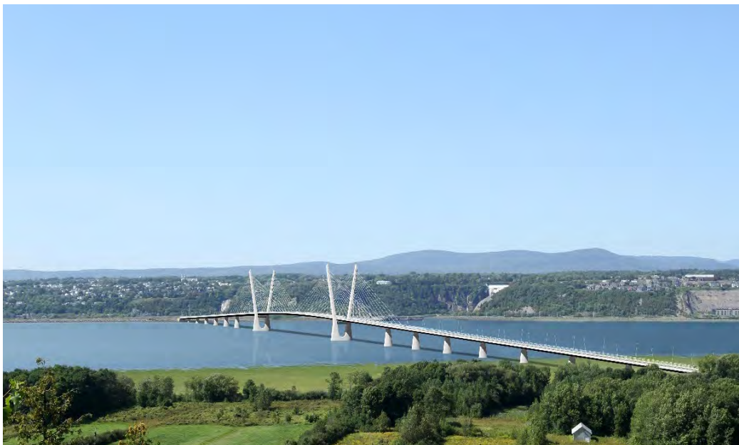
Figure 5-5 Vue du nouveau pont à partir de l'île d'Orléans
