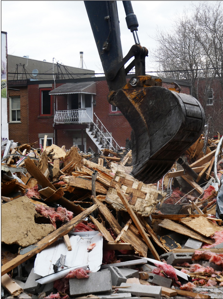
B1-1_ Chantier démolition ordinaire
