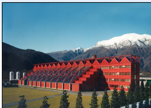
Usine de démonstration
