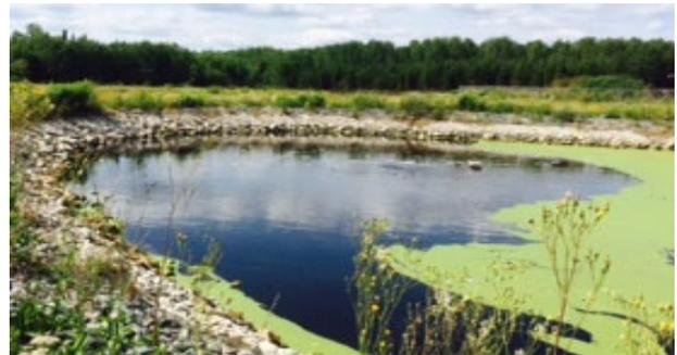
La plateforme de compostage est munie d'un bassin de captage des eaux de lixiviation d'une capacité de 6 500 m<sup>3</sup> (229 545 pi<sup>3</sup>).
