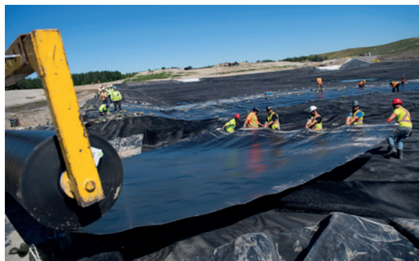
Les cellules d'enfouissement sont imperméabilisées à l'aide de trois niveaux de membranes de protection.
