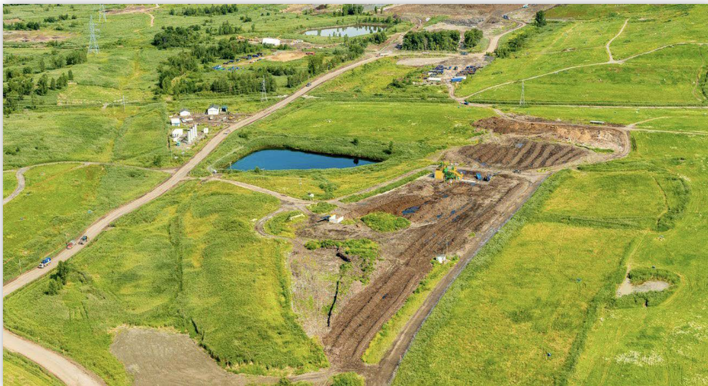
PHOTO 5 - PLATEFORME DE COMPOSTAGE (DEPUIS 2000)
