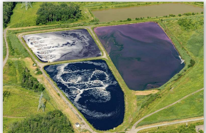
PHOTOS 2 ET 3 BASSINS DE TRAITEMENT DU LIXIVIAT ET SMBR ®
