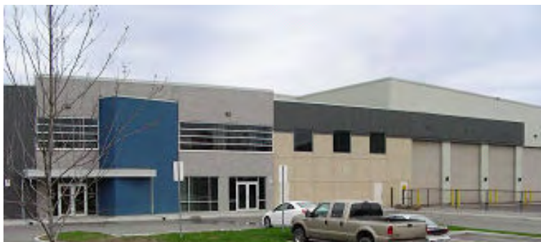
Figure 7-1-1 Centre de compostage centralisé de Hamilton, ON
