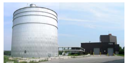
Usine de digestion anaérobie, Ville de Toronto
