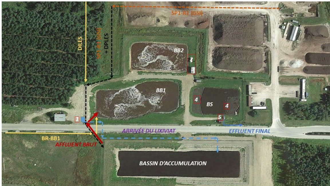
Figure 1 - Installation d'un poste de pompage à la jonction des conduites d'amenées des différentes sources de génération des eaux brutes et relocalisation de la conduite des affluents en passant du côté Est du bassin pour se raccorder du côté opposé au pompage (décharge du bassin) pour acheminer les eaux brutes diluées vers le système de traitement des eaux
