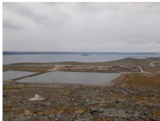
Figure 23: Étang d'épuration de Kangirsuk et LEMN derrière
