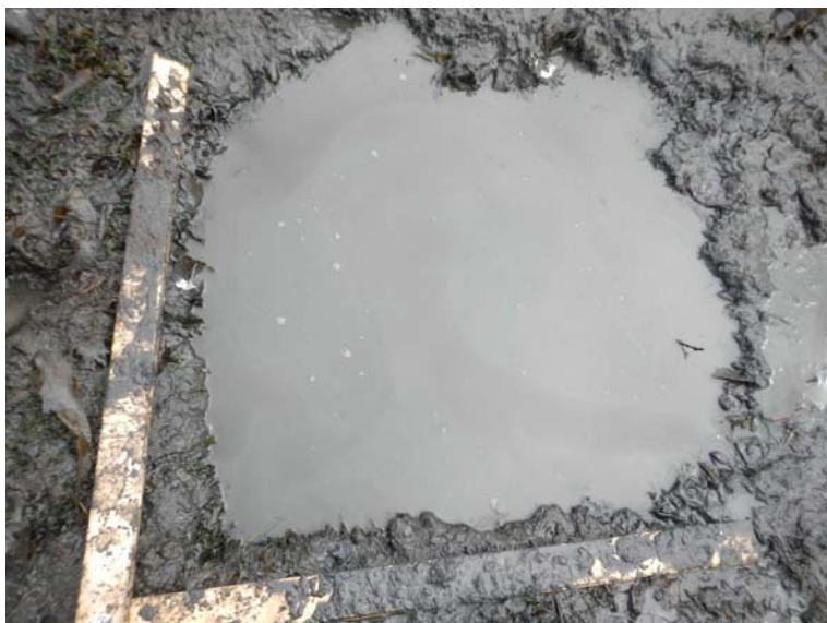
Photo 5. Site d'échantillonnage 135 – Après creusage
