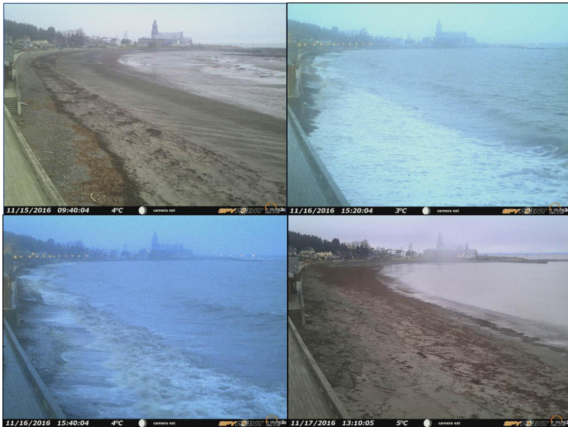
Figure 49. Évolution du front de la recharge lors de la tempête du 16 novembre 2016 (caméra est)
