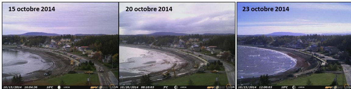
Figure 16. Évolution des travaux de recharge sédimentaire entre le 15 et le 23 octobre 2014 à l'anse aux Coques
