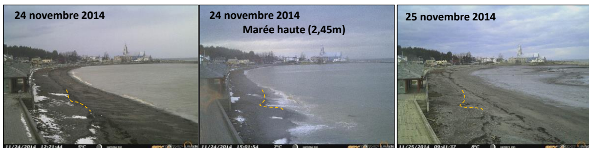
Figure 25. Formation d'une encoche d'érosion sur le front de la recharge sédimentaire lors des hauts niveaux d'eau (2,45 m) du 24 novembre 2014
