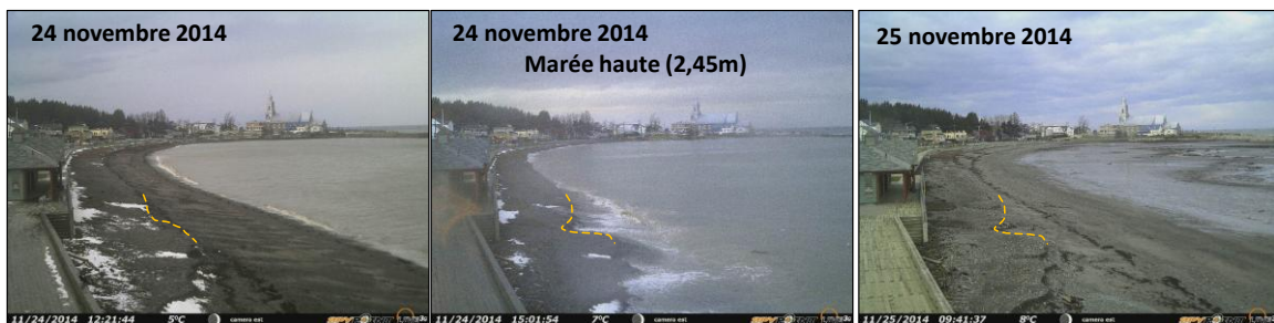
Figure 21. Formation d'une encoche d'érosion sur le front de la recharge sédimentaire lors des hauts niveaux d'eau (2,45m) du 24 novembre 2014
