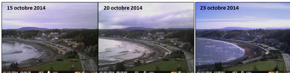
Figure 20. Évolution des travaux de recharge sédimentaire entre le 15 et le 23 octobre 2014 à l'anse aux Coques
